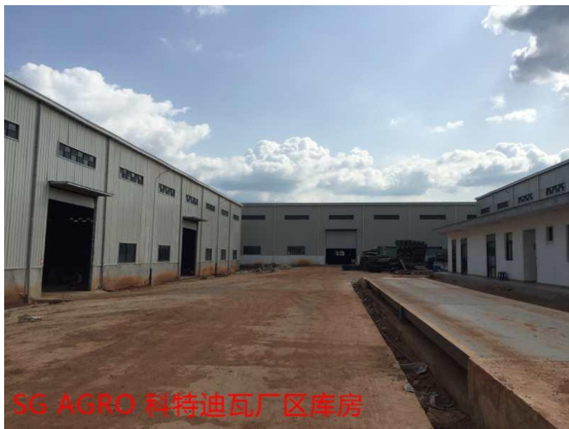
工厂车间和设备区域：
