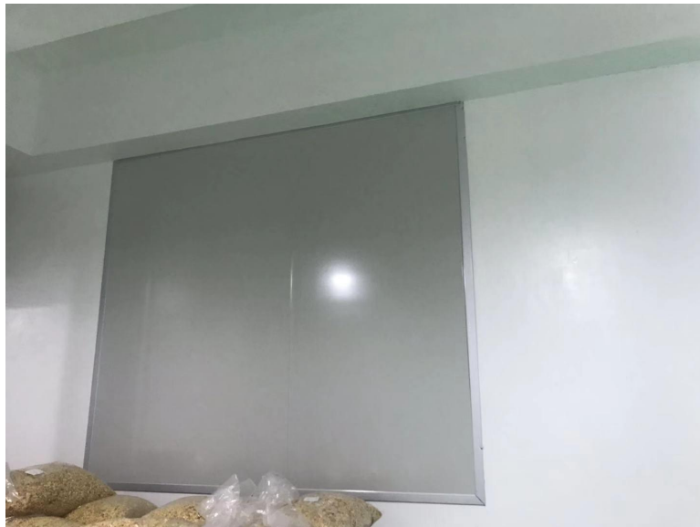
有病虫害风险的窗门进行封闭
